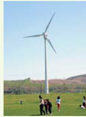
寿都温泉ゆべつのゆ風力発電所(写真提供:寿都町役場)
